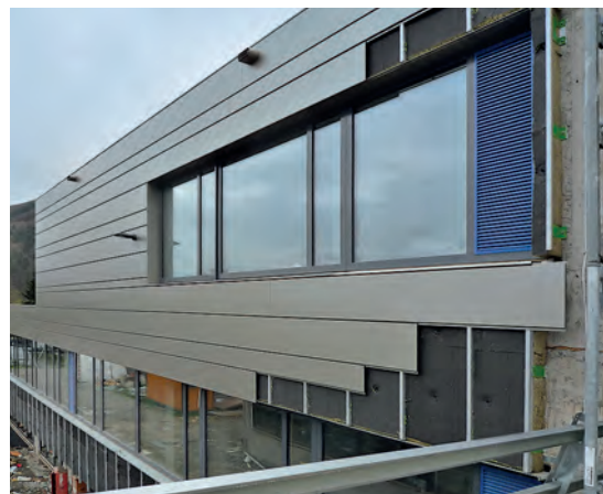
Die Verlegung der Stahlpaneelle erfolgt von oben nach unten, indem Laschen an der oberen Abkantung in Schlitze des darüber liegenden Paneels eingeführt werden. Die Befestigung mit Nieten an der Unterkante wird durch das nachfolgende Element verdeckt.
