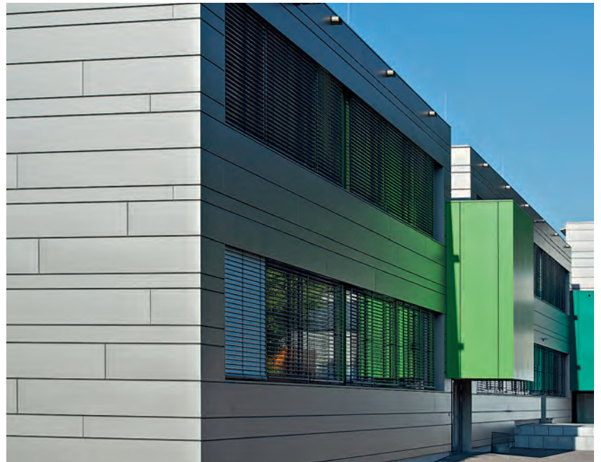
Farbig markierte Eingangsanlagen unterbrechen die silbern schimmernde Fassadenbekleidung des Schulgebäudes.
