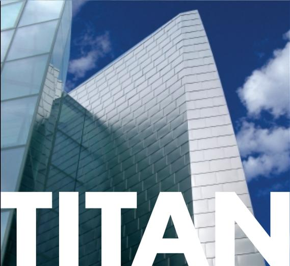
Design Architekten Frank O. Gehry & Associates Inc. (FOG): Zollhof Düsseldorf, Edelstahlfassade mit dreidimensional ständig wechselnden Radien. Realisiert mit Hilfe komplexer geometrischer Abwicklungen im Vorstadium und neuentwickelten Umformtechniken.
