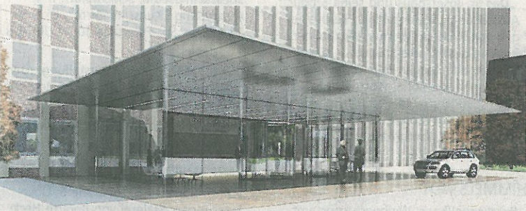
Beim Vordach des VW-Gebäudes in Wolfsburg sind etliche Detaillösungen zu finden.
