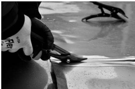
Der Edelstahl wird in Bahnen auf dem Dach verlegt und zugeschnitten.
