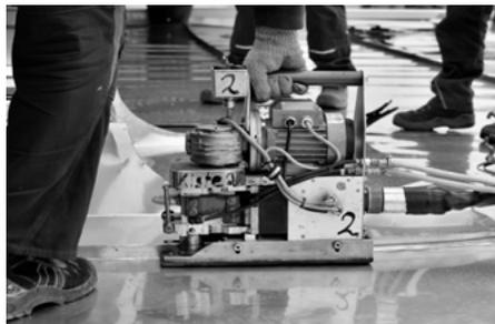
Die Scharen werden mit der Schweißmaschine rollennahtverschweißt.
